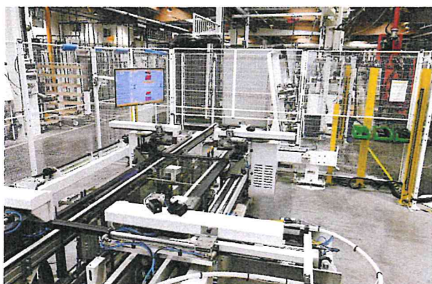
Puis les quatre profils sont positionnés dans la cadreuse. Le vitrage se met à hauteur pour le cadrage, puis le vissage.
